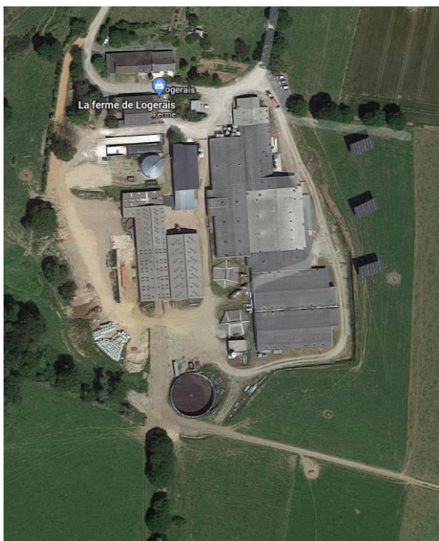
Figure 27 : Vue aérienne (source google maps) mai 2020
