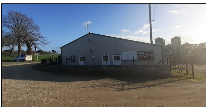
Accès au site (locaux techniques)
